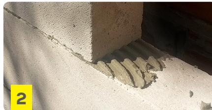
Como mortero adhesivo: colocar **weber celublok** con la llana dentada en la cara horizontal y vertical del bloque. Asentarlo con una masa de goma.
