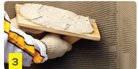
Como puente de adherencia: Humedecer la superficie. Colocar **weber celublok** con llana dentada N°6. Una vez que el material haya secado, aplicar **weber mix I o E**
