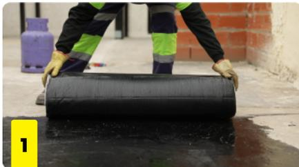
1. Impermeabilizar previamente todos los desagües. Luego colocar los rollos desde la parte más cercana a los mismos hacia la parte más alejada, en forma perpendicular a la pendiente. Extender el rollo a aplicar por completo para verificar su correcta posición. Enrollarlo nuevamente.
