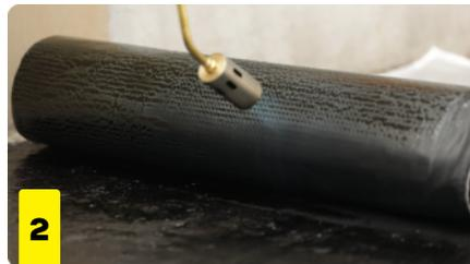
2. Calentar el rollo con soplete en la porción a aplicar hasta fundir completamente el antiadherente. Desenrollar la parte calentada y ejercer una leve presión para ayudar a la adherencia. Solapar el paño consecutivo no menos de 8 cm. en sentido longitudinal. En los extremos de los rollos solapar 15 cm. para evitar cualquier filtración.
