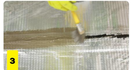
3. Soldar los solapes entre paños calentando con soplete y luego, con una cuchara de albañil, presionar y distribuir el asfalto de exudado para sellar la unión. Aplicar **Megaflex pintura aluminizada** sobre todas las uniones de paños para proteger el asfalto expuesto al soldar.
