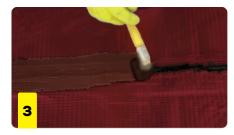
3 . Soldar los solapes entre paños calentando con soplete y luego, con una cuchara de albañil, presionar y distribuir el asfalto de exudado para sellar la unión.
