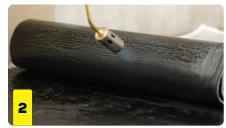
2. Calentar el rollo con soplete en la porción a aplicar hasta fundir completamente el antiadherente. Desenrollar la parte calentada y ejercer una leve presión para ayudar a la adherencia.
