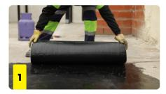
1. Impermeabilizar previamente todos los desagües. Luego colocar los rollos desde la parte más cercana a los mismos hacia la parte más alejada, en forma perpendicular a la pendiente. Extender el rollo a aplicar por completo para verificar su correcta posición.
