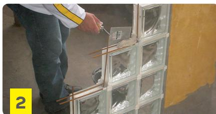
**2** Aplicar el material sobre la superficie y asentar el ladrillo realizando presión sobre el mismo. Para las hiladas sucesivas aplicar el material en ambas caras.
