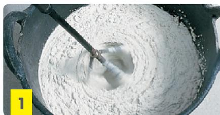
**1** Amasar el material con aproximadamente 5 litros de agua limpia por bolsa de 25 kg (1 litro de agua cada 5 kg), manual o mecánicamente, hasta obtener una mezcla uniforme y de color homogéneo. Dejar reposar 5 minutos.
