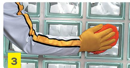
**3** Retirar el exceso de material y rellenar faltantes de ser necesario. Dejar secar por 30 minutos y alisar las juntas con rejuntador. Para una mejor terminación limpiar con una esponja húmeda.
